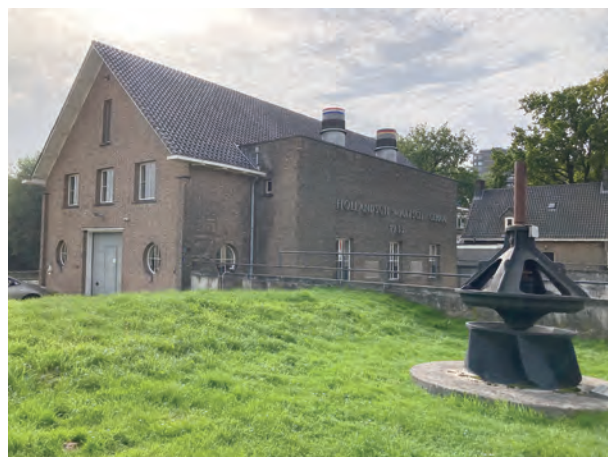
図1 オランダ・ドイツポンプ場全景
