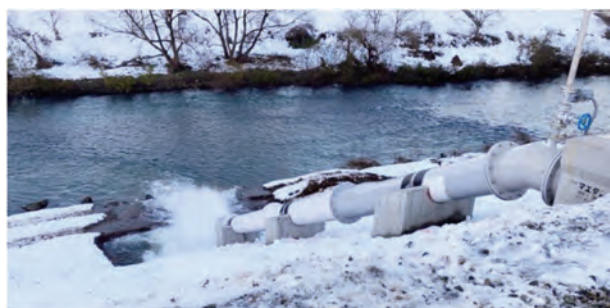
図10 試運転状況 Fig.10 Demonstration test status
