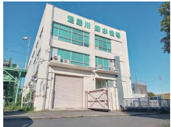
図3 機場外観と防水扉
