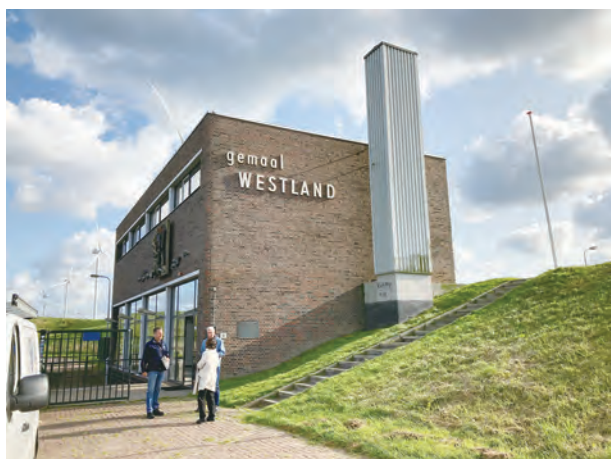
図9 ウェストランドポンプ場外観
