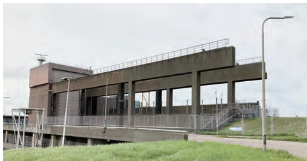
図11 アイマウデンポンプ場外観
