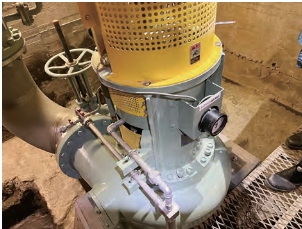
図6 立軸斜流ポンプ
