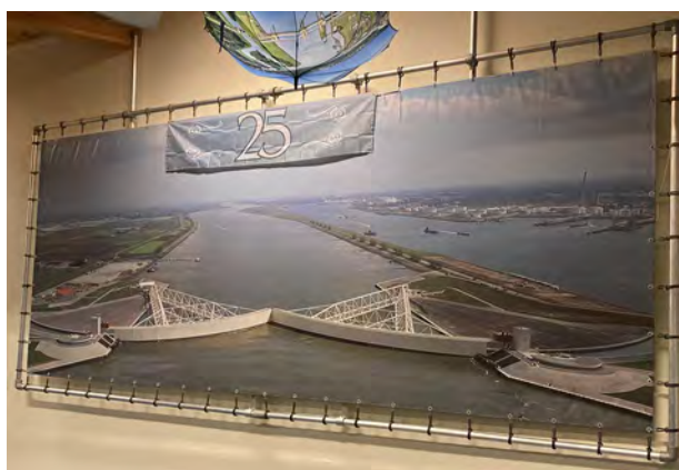
図8 防潮水門全体像
