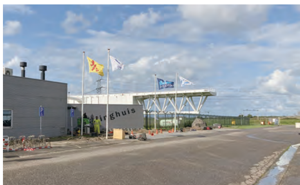
図7 防潮水門外観
