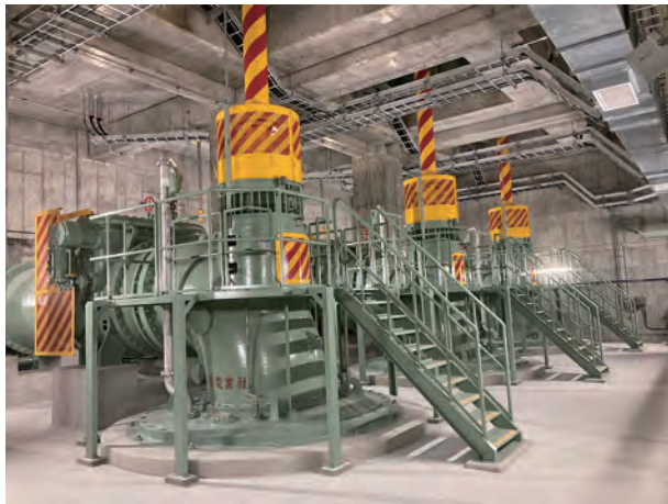
図3 雨水ポンプ室全景
