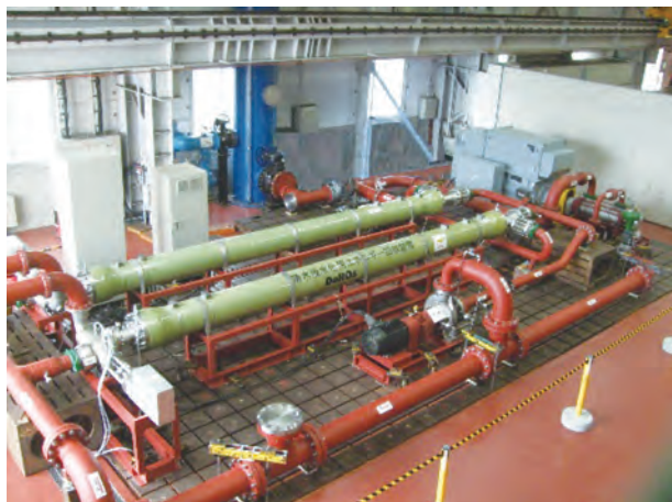
図5 逆浸透膜法海水淡水化淡水化用エネルギー回収装置 (DeROs®)
