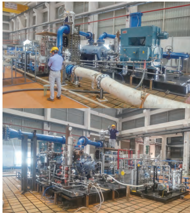
図2 3 400 kW高圧多段ポンプ試運転作業中
