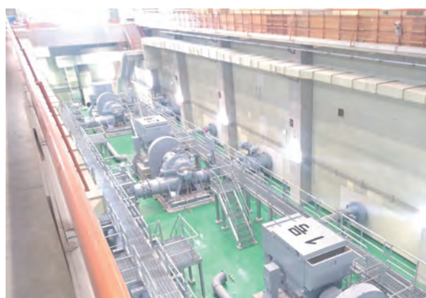
図5 ポンプ据付完了状況
