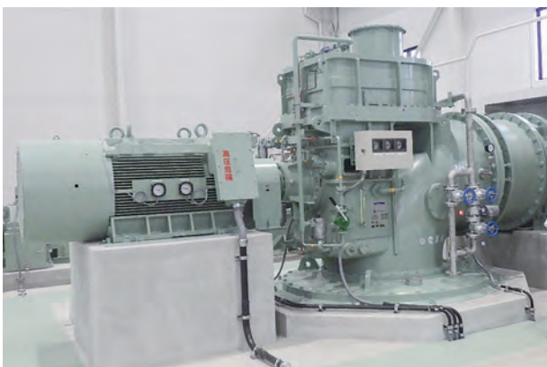
図3 歯車減速機搭載型立軸斜流ポンプ外観
