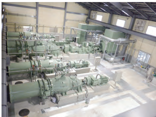
図1 横軸斜流ポンプ
