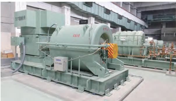
図4 口径600/500 mm 鑄鉄製多段ターボブロワ
