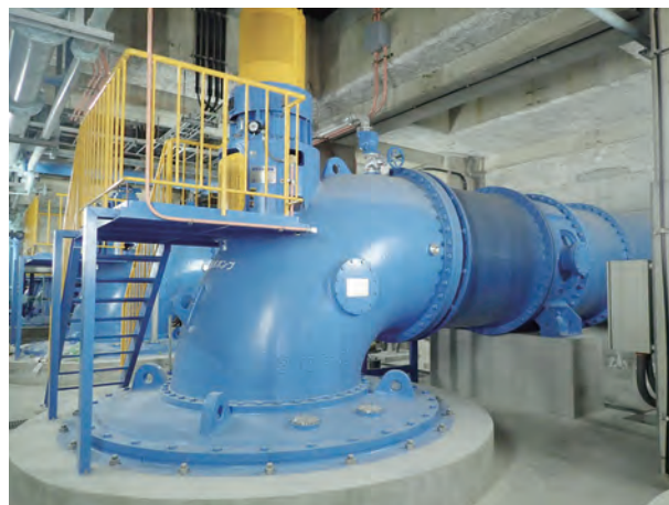
図2 立軸斜流ポンプ
