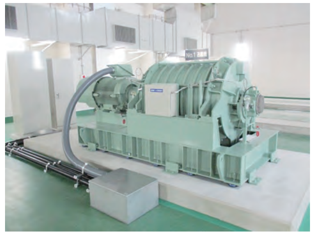
図5 鋼板製多段ターボブロワ
