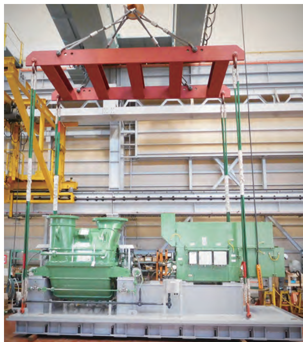
図5 機器の一体吊り Fig.5 Single point lifting of the blower
