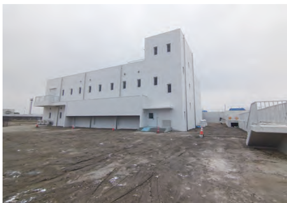
図1 送風機棟外観
