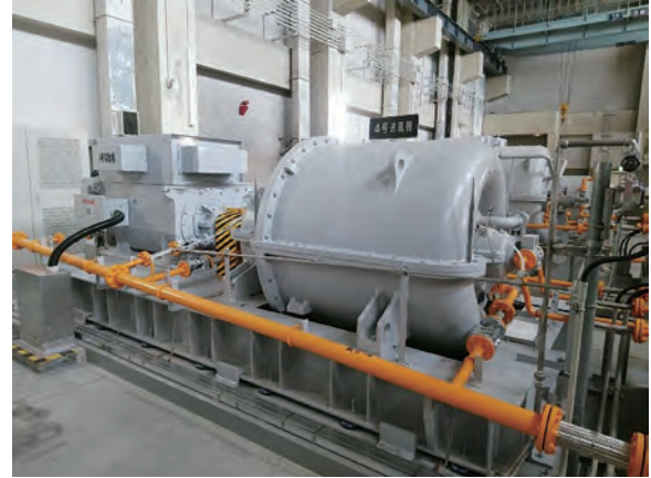
図8 鋳鉄製多段ターボブロワ
