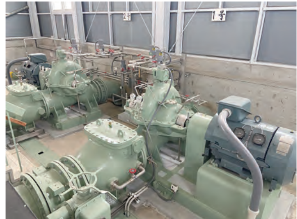
図4 横軸両吸込渦巻ポンプ
