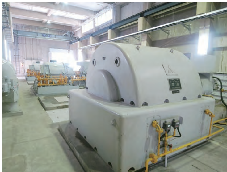
図1 既設状況写真
