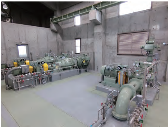
図3 横軸両吸込渦巻ポンプ
