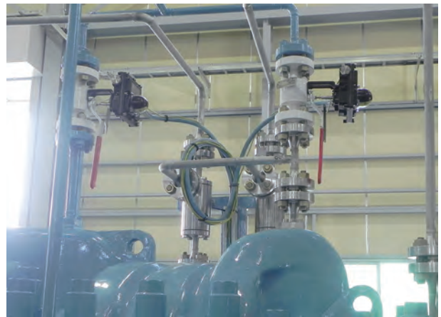
図5 リミットスイッチ付きバルブ Fig.5 Valve with Limit Switch
