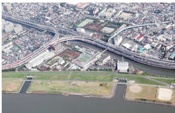
図1 小菅水再生センター全景
