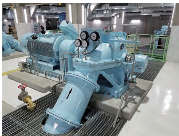
図5 配水ポンプ据付完成状況
