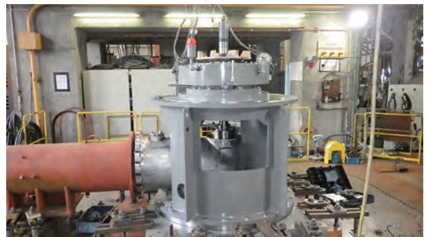
図7 工場試運転前の組立の様子
