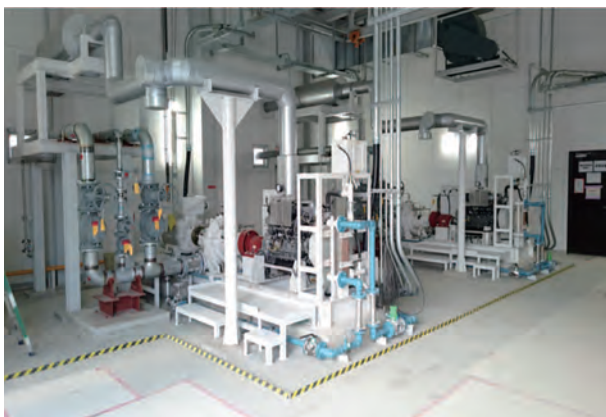
図9 200×150 mm横軸両吸込渦巻ポンプ
