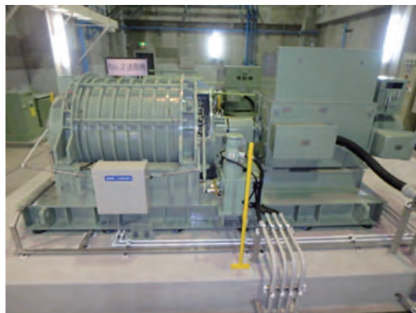
図14 片吸込多段ターボブロウ
