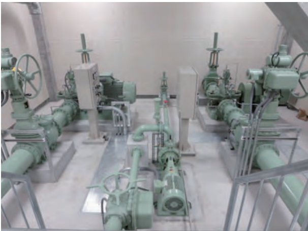
図3 ポンプ室全景
