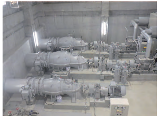
図2 ポンプ室全景
