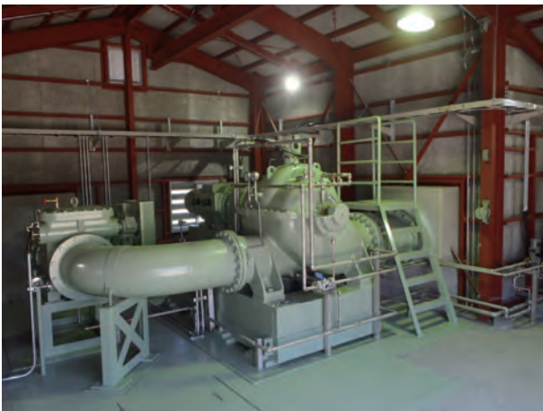
図1 横軸両吸込渦巻ポンプ
