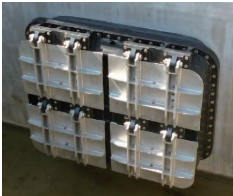
図8 逆流防止弁外観
