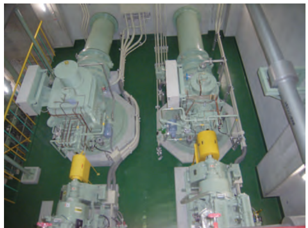
図5 減速機搭載型立軸斜流ポンプ
