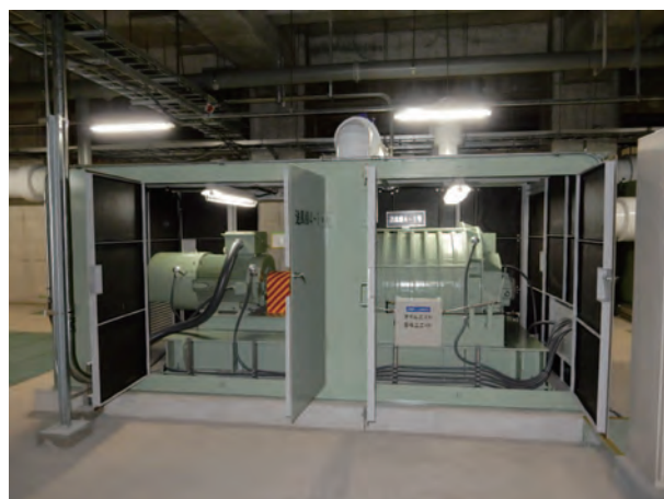
図12 防音カバー付鋼板製片吸込多段ターボブロワ
