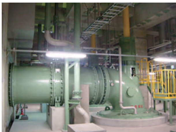
図6 口径1 500 mm先行待機形立軸斜流ポンプ
