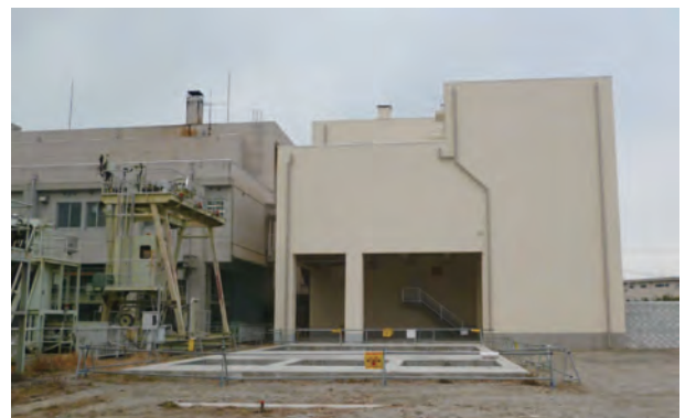
図2 既設ポンプ棟および新設ポンプ棟外観
