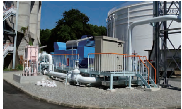
図10 横軸両吸込渦巻ポンプ
