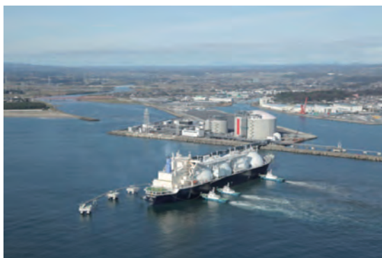
図1 日立LNG基地全景①
