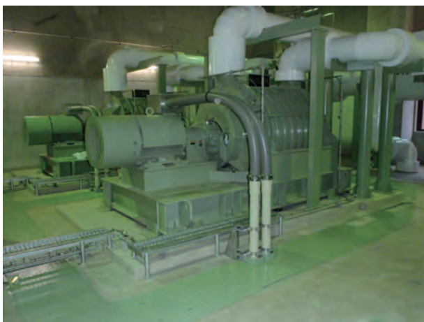
図11 口径200×200 mm鋼板製直結式多段ターボブロワ
