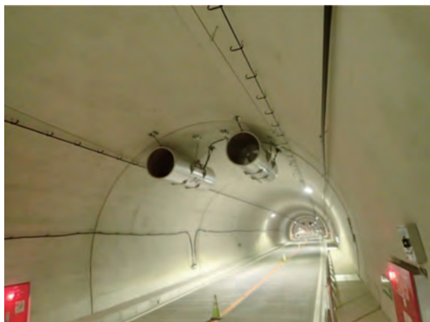
図13 ジェットファン設置状況
