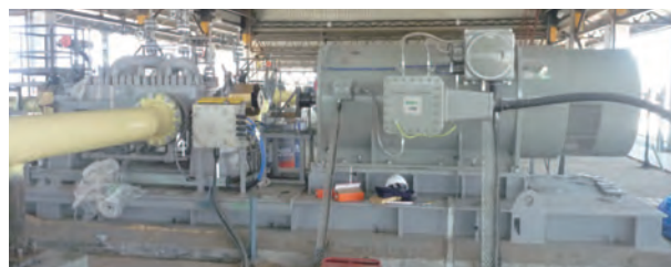
図8 現地ポンプ据付 Fig.8 Pump installation
