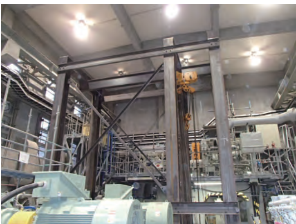
図5 仮設門形クレーン Fig.5 Provisional gate crane
