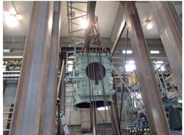
図6 ポンプ搬入状況 Fig.6 Carrying pump
