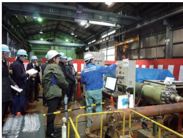
図2 エネルギー回収装置の説明状況
