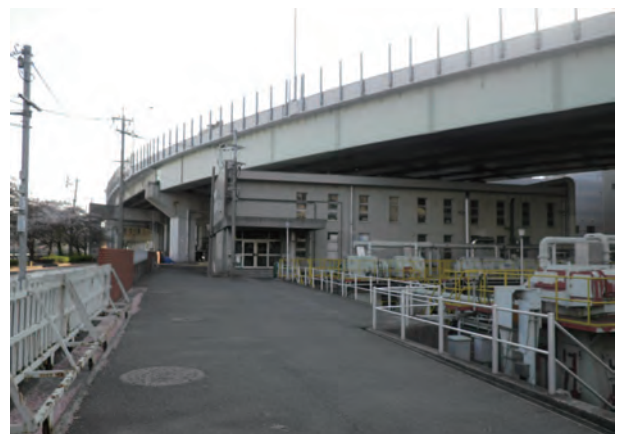
図2 大手町ポンプ場全景
