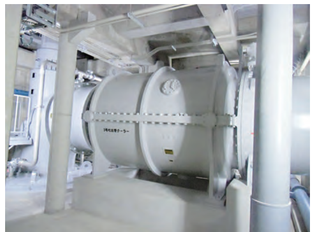
図2 口径1 650 mmコイル式管内クーラ
