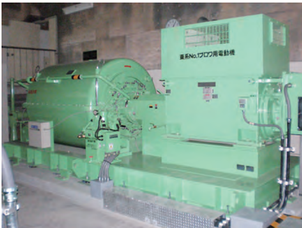
図10 口径500 mm×450 mm 鋳鉄製多段ターボブロワ
