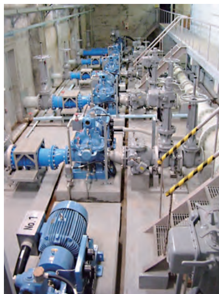
図4 ポンプ室全景
