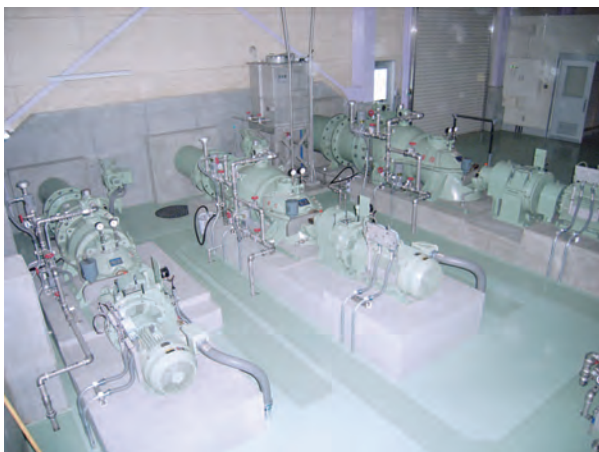
図1 ポンプ室全景
