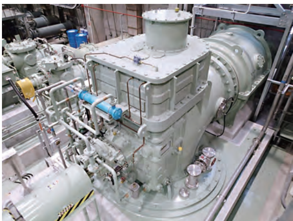
図3 口径1 350 mm先行待機型減速機搭載型立軸斜流ポンプ
