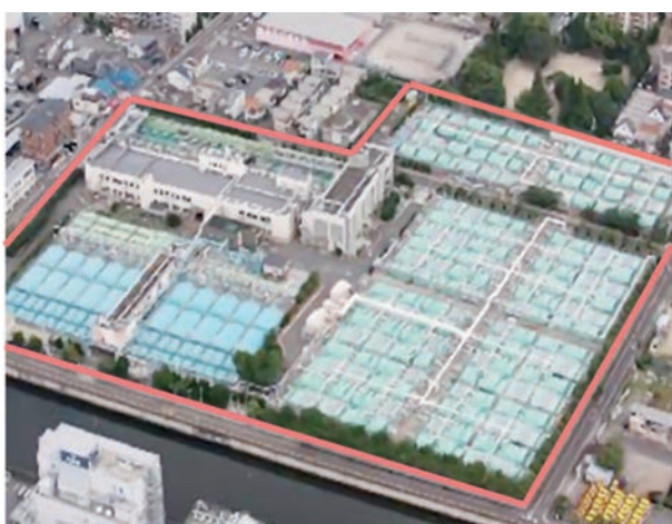
図1 今福下水処理場全景
