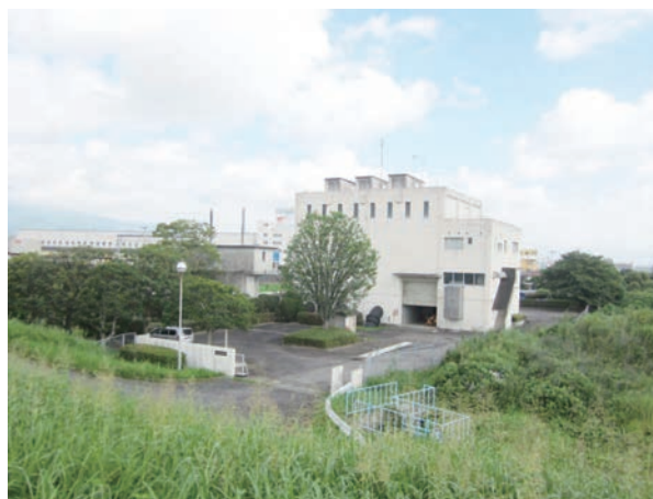
図2 前川排水機場全景
