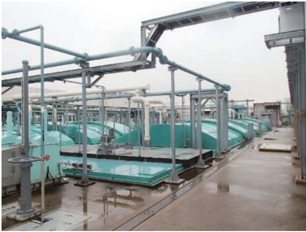
図7 南反応槽（仮設汚泥ポンプ井） Fig.7 South reactor
