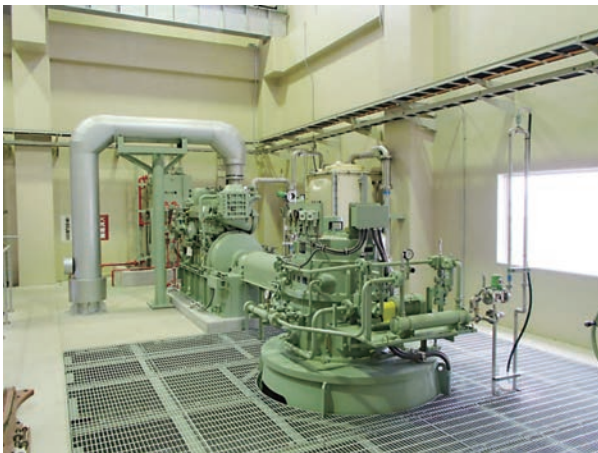
図3 ポンプ室外観
