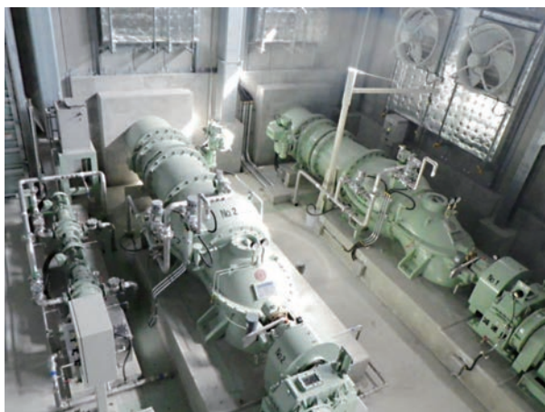
図1 口径1 000 mm横軸斜流ポンプ
