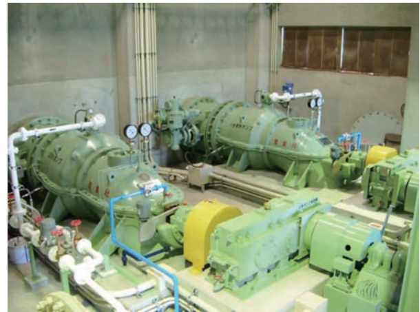
図7 口径1 000 mm横軸斜流ポンプ
