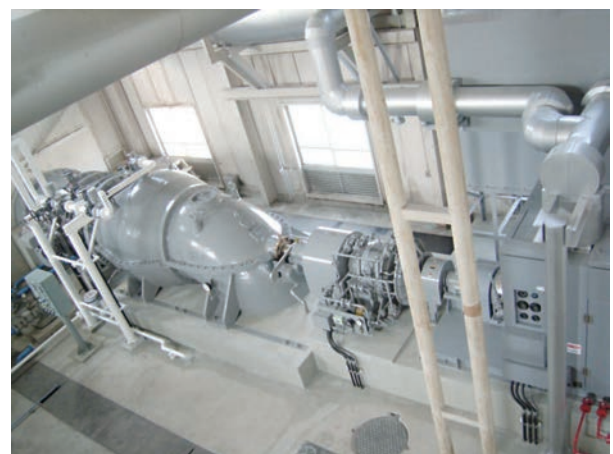
図5 口径1 500 mm横軸斜流ポンプ
