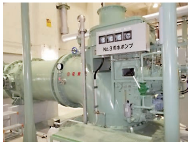
図2 口径1 200mm減速機搭載型エルボ(ラムダ21)
