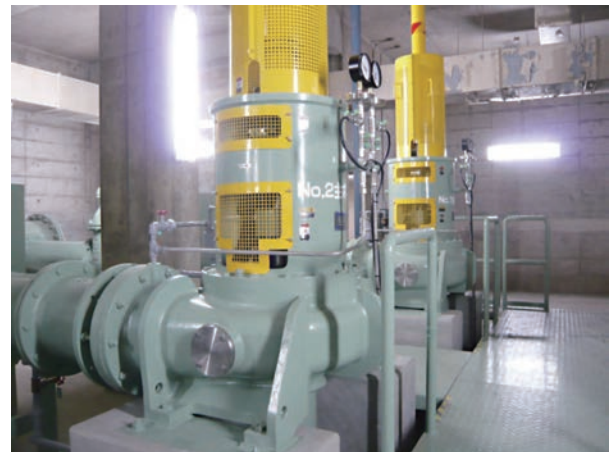
図4 口径350 mm立軸渦巻斜流ポンプ
