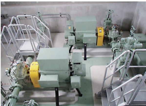
図6 口径200 mm両吸込渦巻ポンプ
