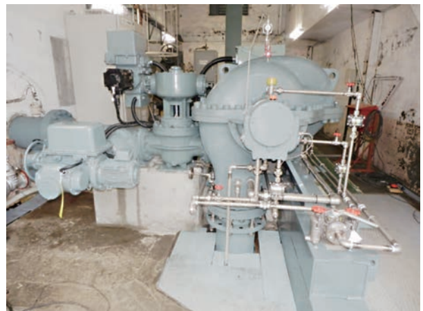
図13 ロート弁、横軸片吸込多段渦巻ポンプ
