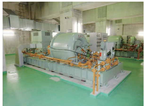
図16 口径550 / 500 mm鋳鉄製多段ターボブロワ
