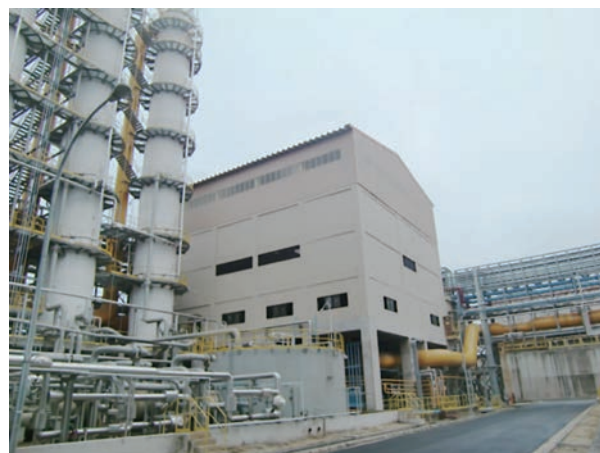
図10 コークスプラントブロワ棟 Fig.10 Coke plant blower building
