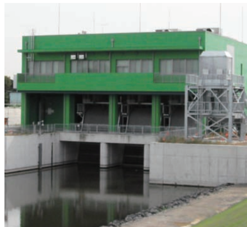
図1 東小川排水機場全景
