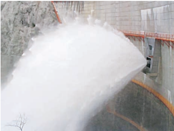
図4 空中拡散放水 Fig. 4 Water discharge into the air
