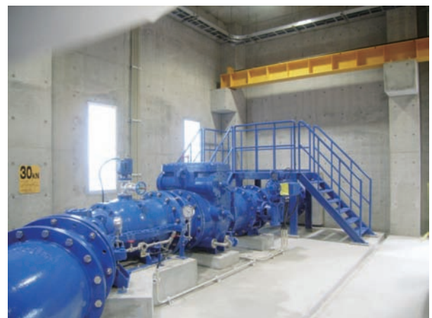
図5 ポンプ設置状況
