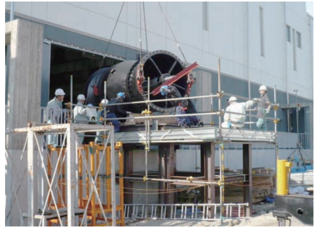
図6 搬入用仮設ステージ Fig.6 View of temporary stage for import
