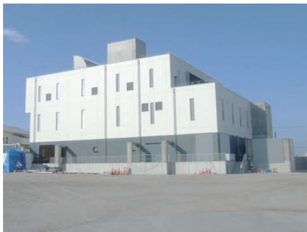
図1 新南駒栄ポンプ場
