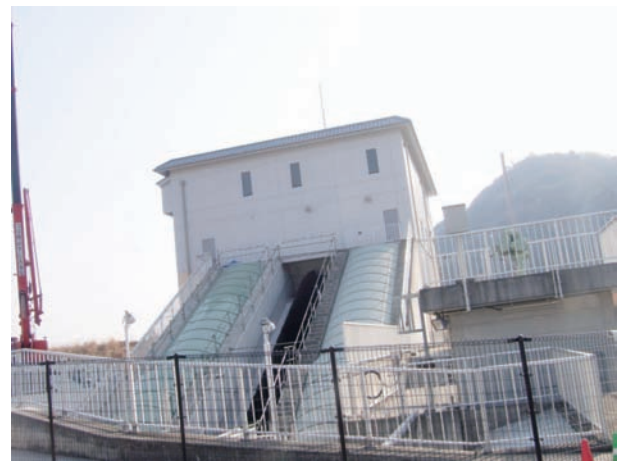
図5 ポンプ場全景
