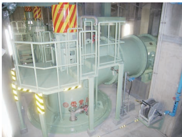
図6 ポンプ設置状況
