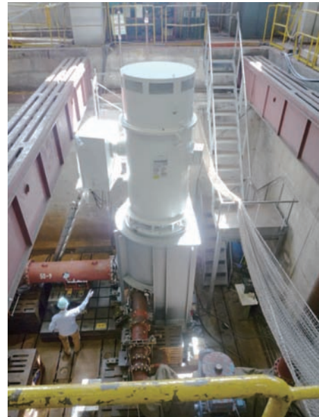
図15 ポンプ性能試験状況
