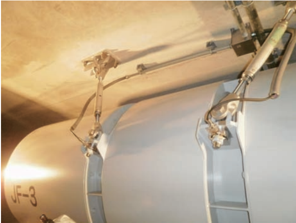
図16 センサ取付図
