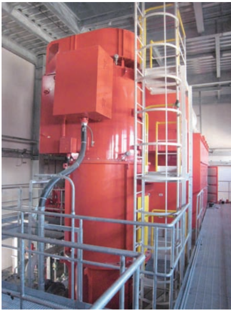
図14 消防火海水ポンプ据付状況
