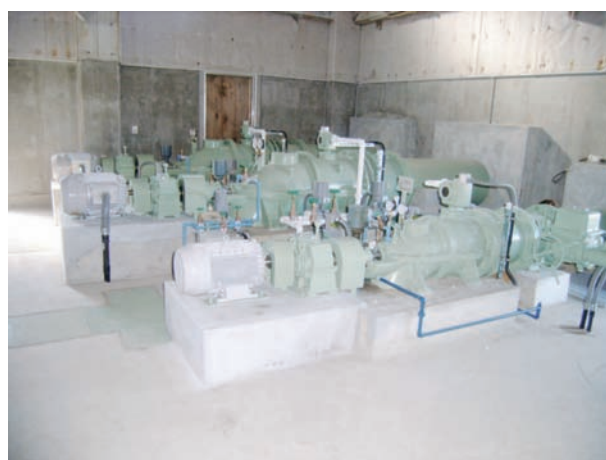
図7 ポンプ復旧状況
