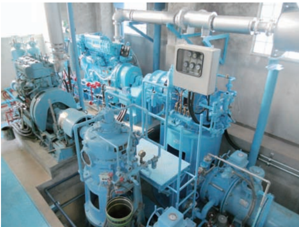
図4 ポンプ設置状況
