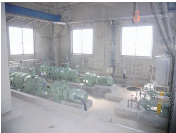
図1 ポンプ設置状況
