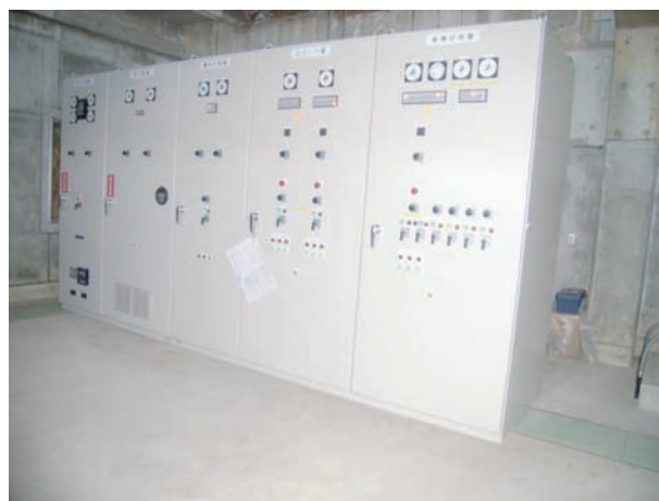
図8 ポンプ復旧状況
