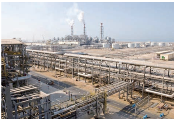
図1 ラービグ1 ペトロケミカルプラント
