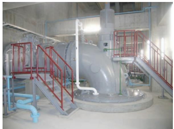
図3 ポンプ設置状況
