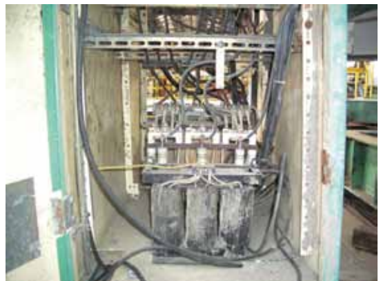
図2 既設ブロワ起動盤内部状況
