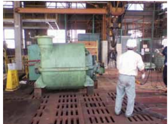
図1 燃焼空気用ブロワ工場搬入状況
