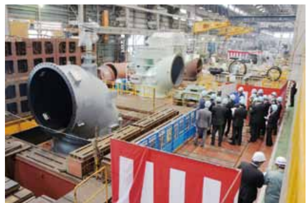
図5 循環水ポンプの説明状況
