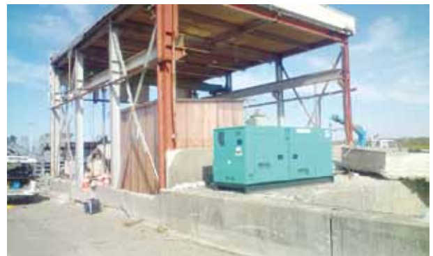
図3 復旧後機場外観
