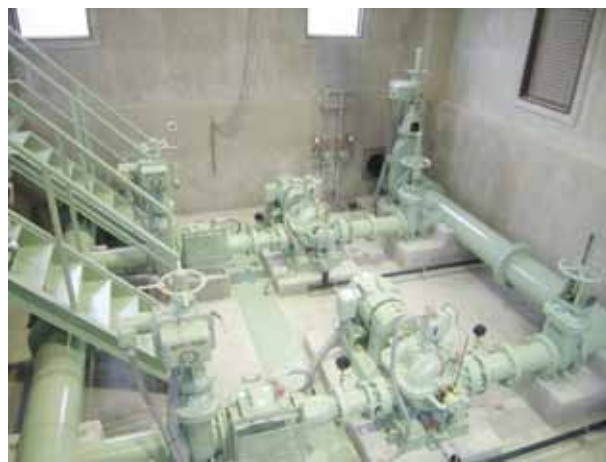
図2 ポンプ室全景
