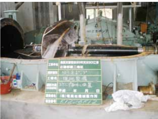
図10 ポンプ現地整備状況
