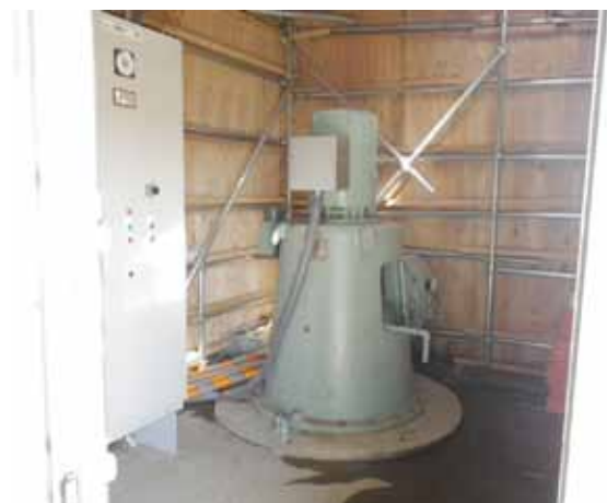
図4 復旧後主ポンプ外観
