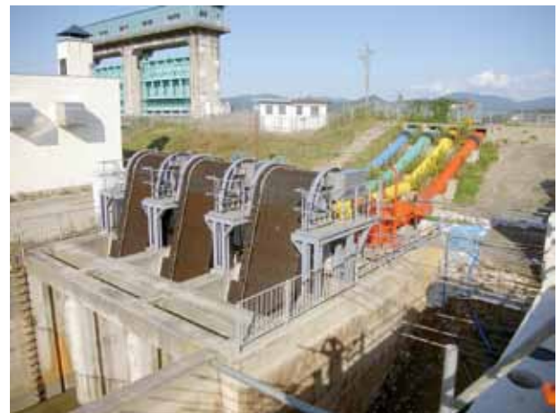
図2 旧八代排水機場全景
