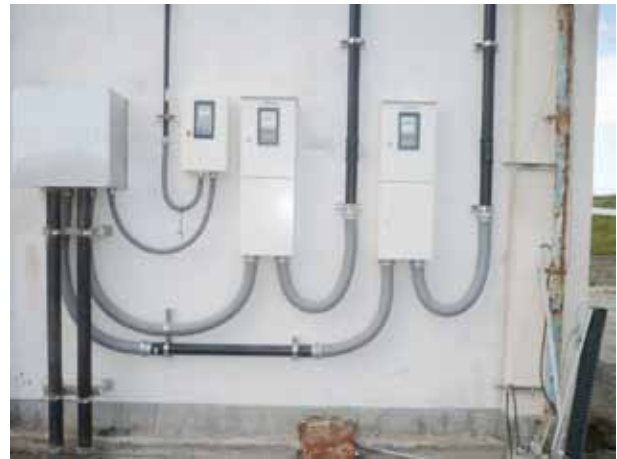
図8 復旧後受電設備
