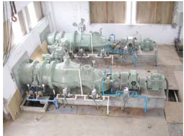
図7 復旧後主ポンプ外観
