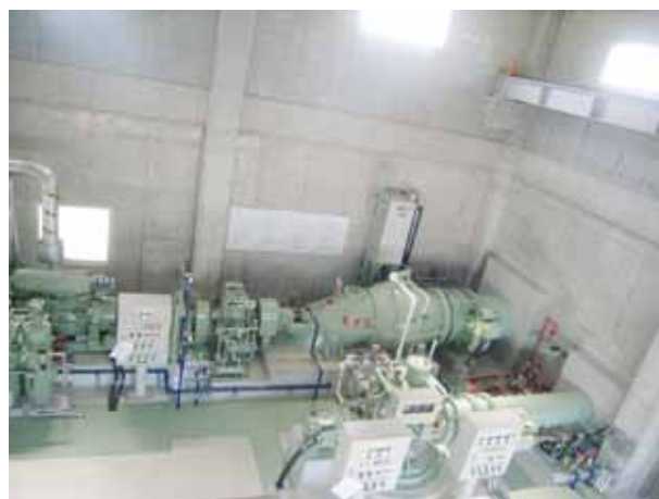
図4 ポンプ設置状況
