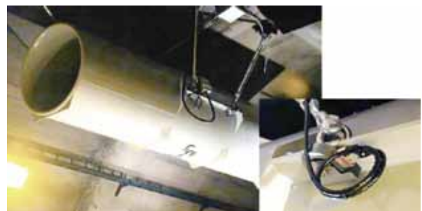
図9 ジェットファン異常検知システム(センサ部) Fig.9 Jet-fan monitoring system for damage detection (sensor)
