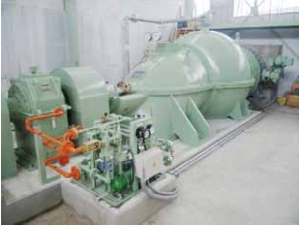
図5 ポンプ設置状況
