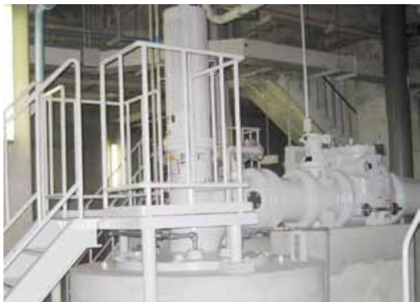
図3 ポンプ設置状況
