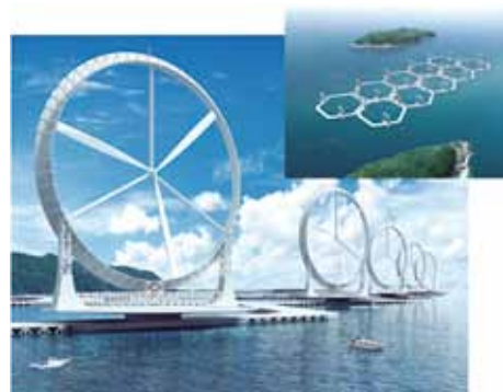
図3 大型風レンズ風車を利用した浮体式洋上風力発電システム
