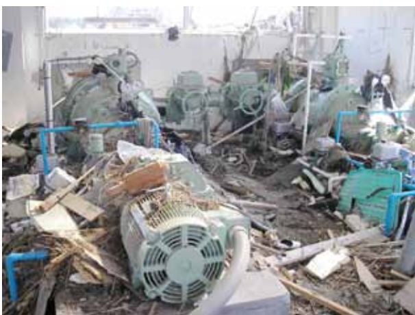
図6 被災後主ポンプ外観
