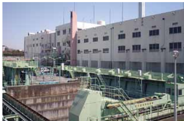
図1 前島ポンプ場外観
