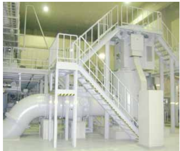
図2 ポンプ室全景
