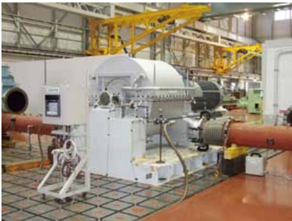
図16 ブロワ組立状況
