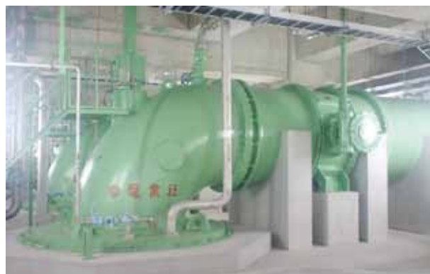
図2 口径2 000 mm雨水ポンプ外観
