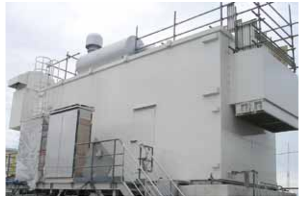
(b) 消火海水ポンプ用ディーゼルエンジン
