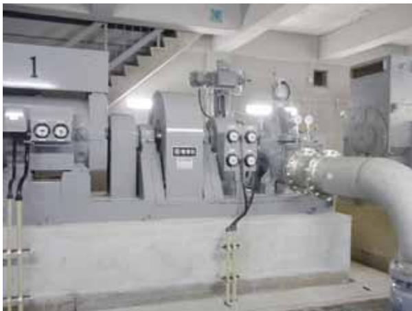
図6 ポンプ設置状況
