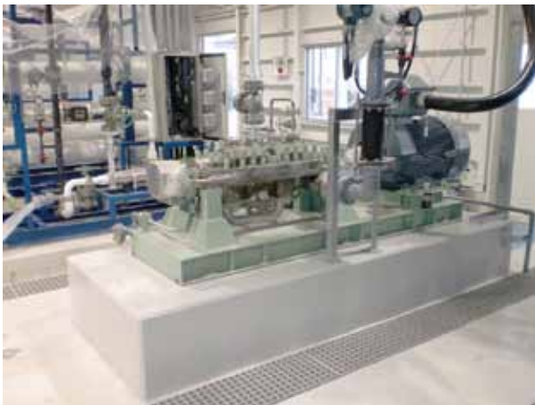
図10 ポンプ設置状況
