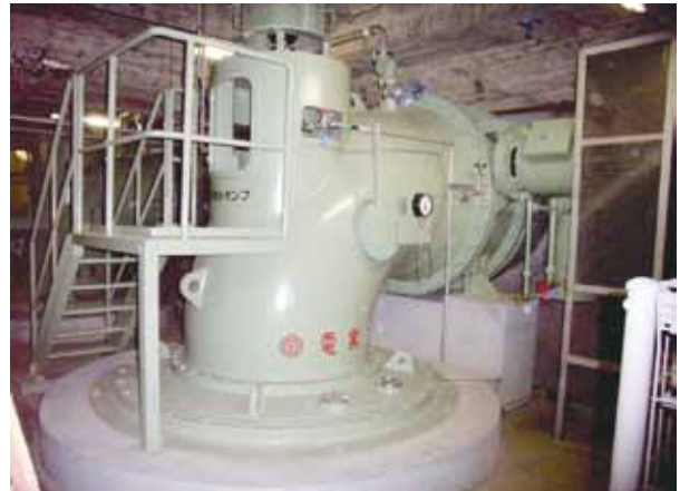
図4 ポンプ設置状況
