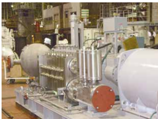
図8 ポンプ設置状況
