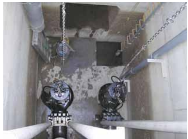
図7 ポンプ設置状況
