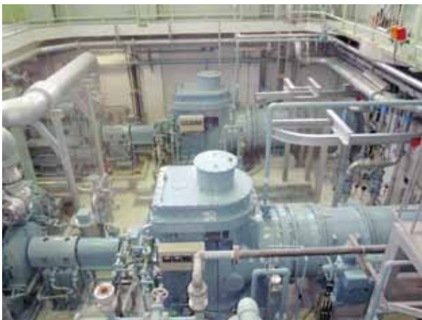
図3 ポンプ室全景
