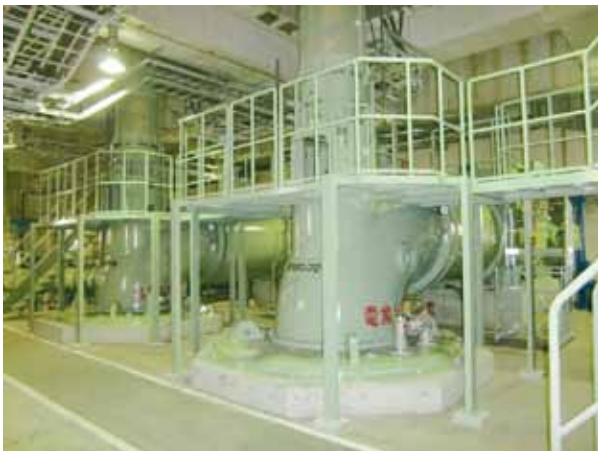
図1 ポンプ室全景
