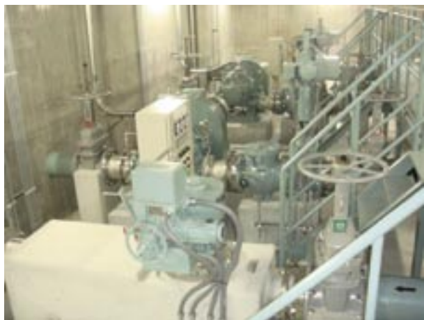
図9 ポンプ設置状況
