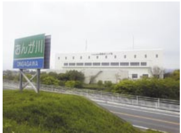
図4 ポンプ場全景
