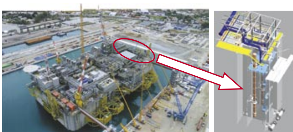
建造中のGBS式LNG設備
