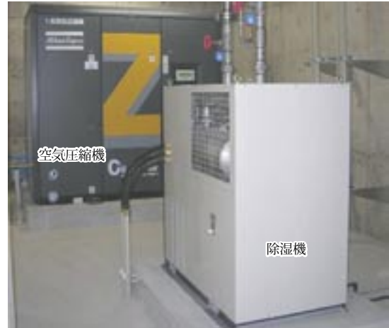
図10 空気圧縮機と除湿機 Fig.10 View of air compressor
