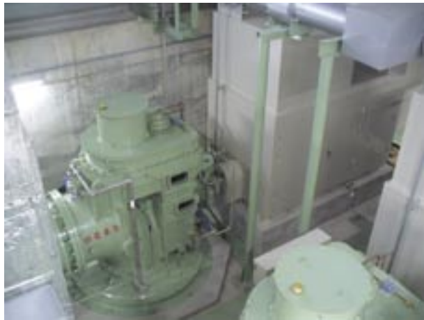
図3 ポンプ設置状況
