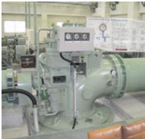
図6 ポンプ設置状況
