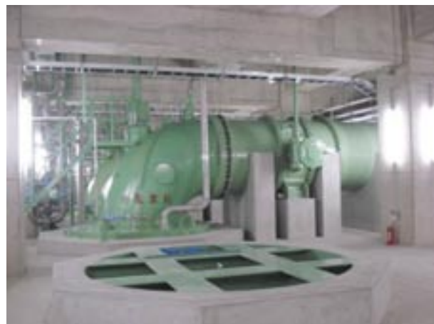
図2 ポンプ設置状況
