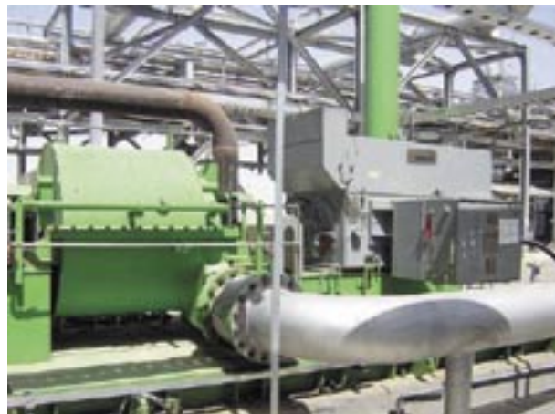
図6 ブロワ現地据付状況（鋼板製）
