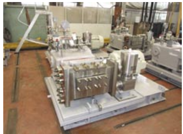
図10 ポンプ設置状況(3連プランジャーポンプ)
