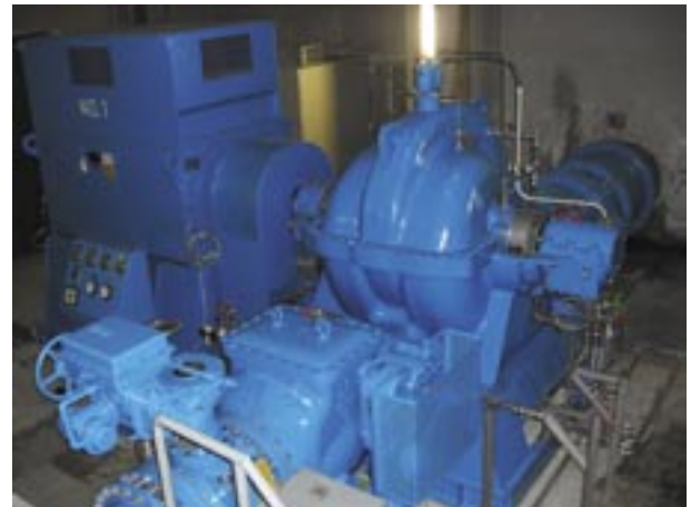
図8 ポンプ設置状況
