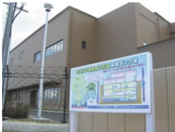
図1 ポンプ場外観
