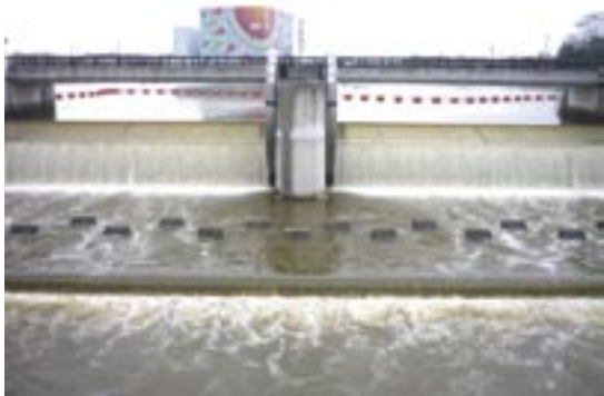
図4 ファジー制御による自動運転時の広口池分流堰 Fig. 4 Rising sector gates controlled by fuzzy logic control
