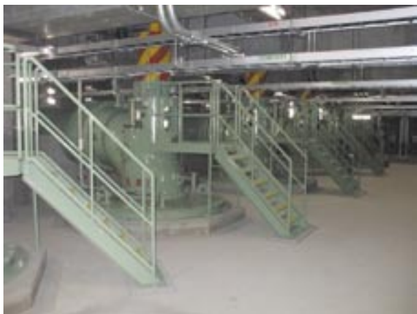
図1 ポンプ設置状況
