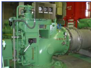
減速機搭載型立軸ポンプ(ラムダ-21)
