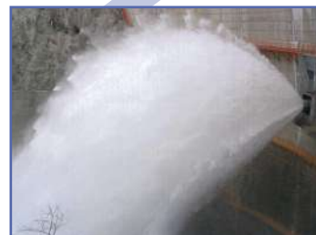
ハウエル・バンガー・バルブ (空中拡散放水)
