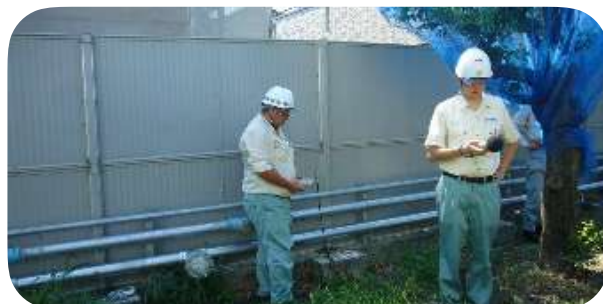
敷地境界の騒音・振動測定
