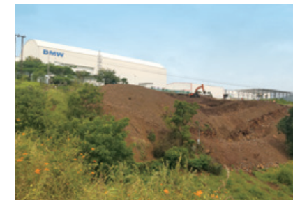
現在の工事状況
