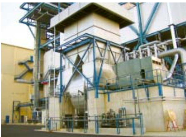
図 4 FDF全景 Fig. 4 View of FDF at site
