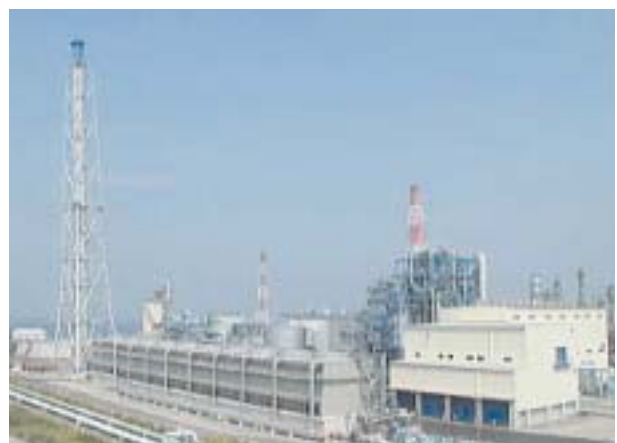
図3 第3号発電設備建設エリア全体 Fig. 3 View of IPP
