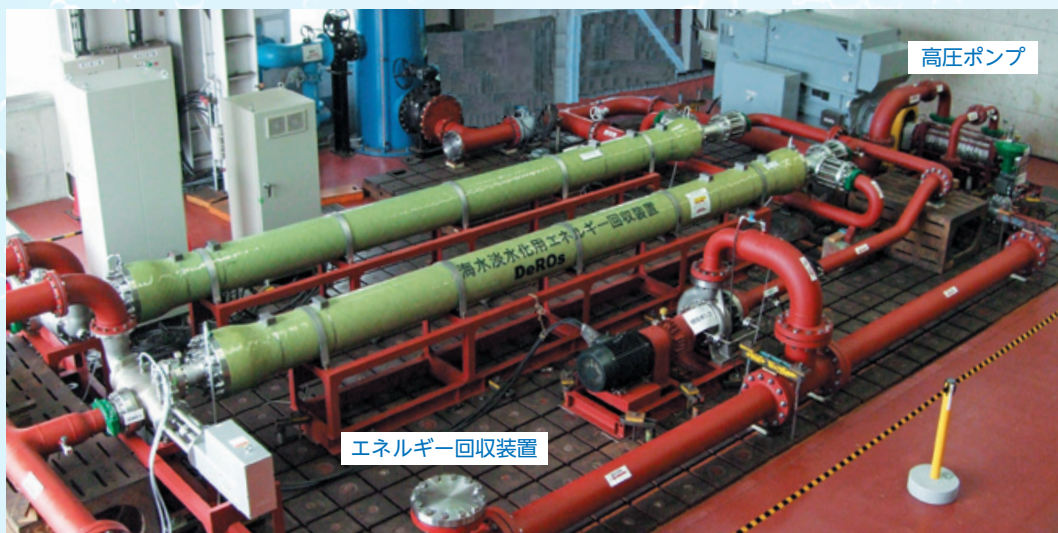
高圧ポンプと組み合わせたエネルギー回収装置
