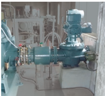
● 水道取水場導水ポンプ設備向け電動式ロートバルブ
