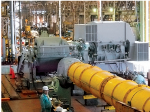
●工場試運転中の硫黄回収用多段ブロウ
