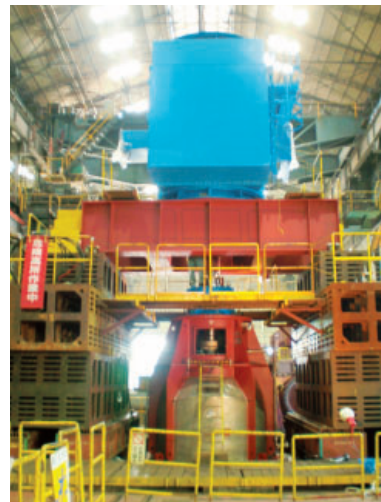
◇ポンプ（工場）据付状況外観
