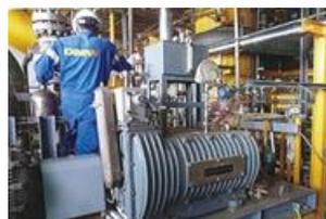
試運転検査中の高圧プランジャポンプ
