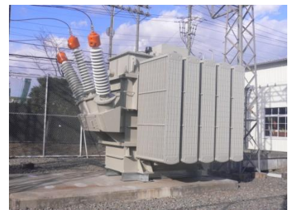
受電用変圧器 10000kVA
