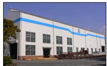
二重化した工場建屋壁
